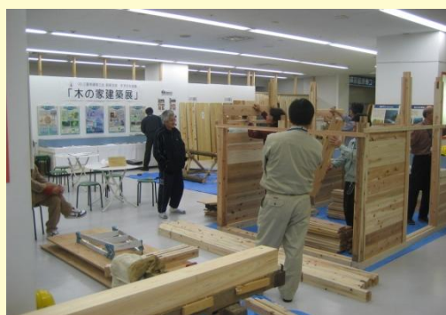
木造の小屋を組立中・・・
