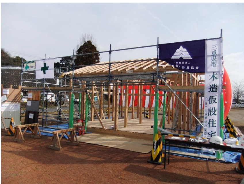
完成した仮設住宅
